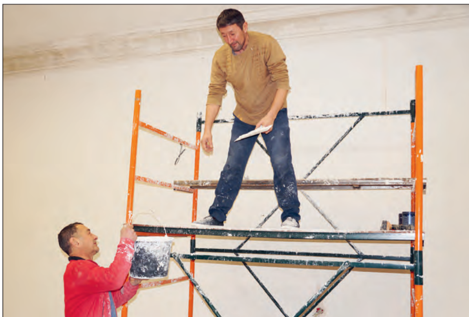
■ Ремонтные работы в «Доме народном» ведутся в соответствии с графиком
