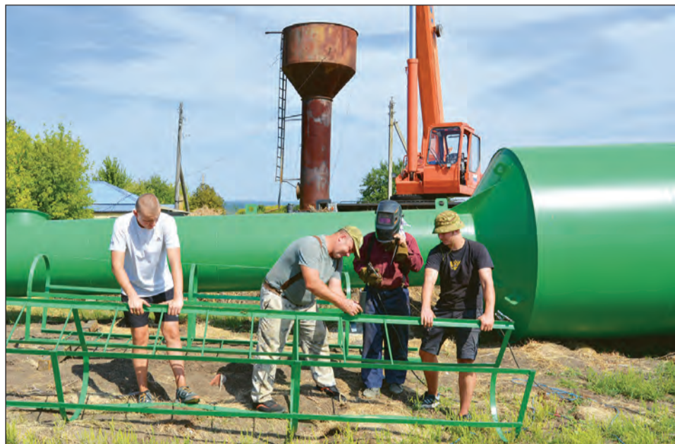
■ Подготовка к установке башни Рожновского
