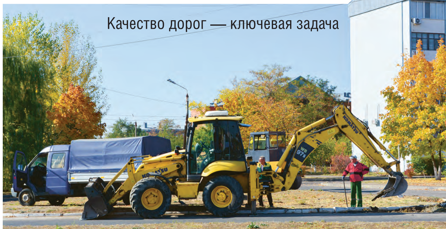
■ В начале октября в военном городке произведен ремонт дорожного покрытия
