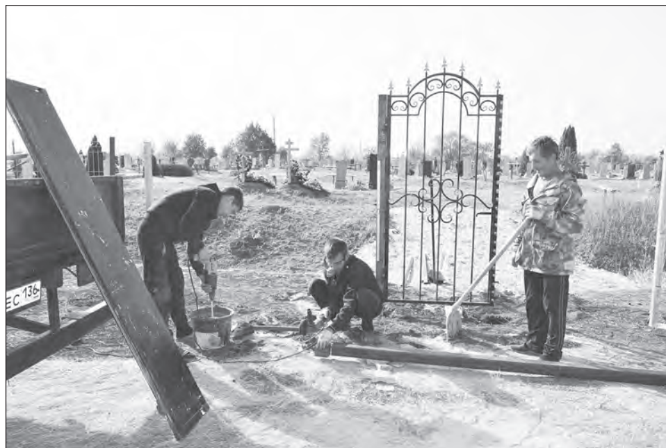
Идет установка ограждения на сельском кладбище
