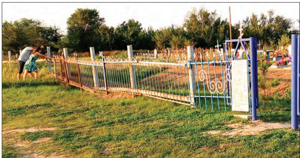
■ Активисты ТОСа проводят демонтаж старого ограждения кладбища
